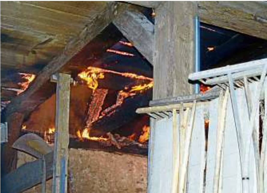
In einer Scheune in Rockendorf brach in der Nacht zum Sonnabend aus bisher unbekann- ter Ursache ein Feuer aus. Foto: Mike Nieber
